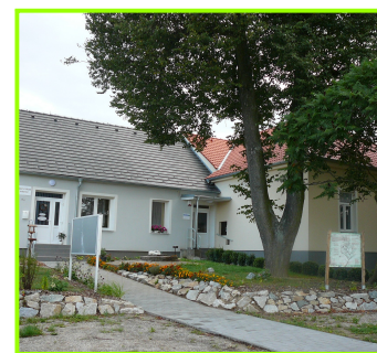
4. Obecní úřad a kulturní dům Střítež, rok 2013 Fotografie - po ukončení celkové rekonstrukce budovy.
